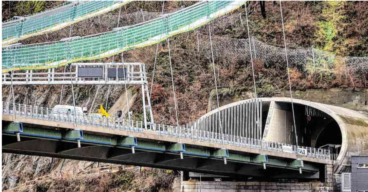
Die A26-Brücke über die Donau soll im heurigen November für den Verkehr freigegeben werden.
